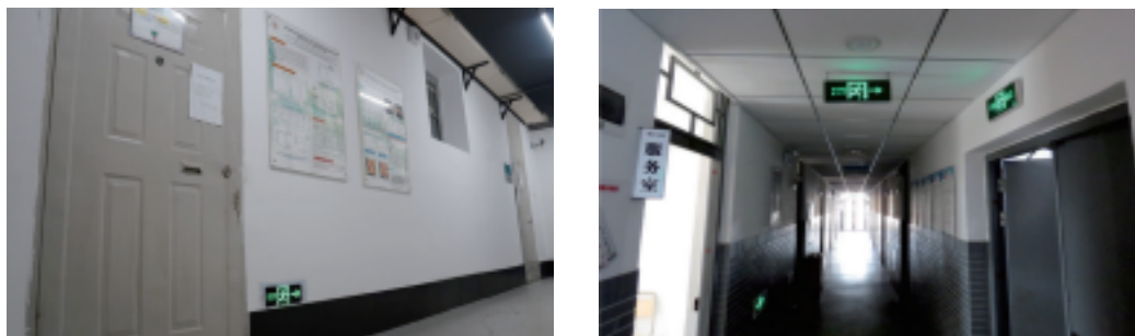
图 1-9疏散指示标志灯工作状态
