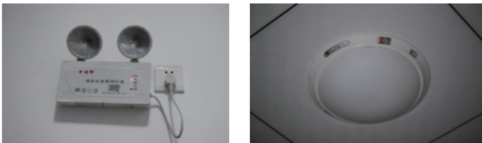
图 1-7 应急照明灯工作状态
