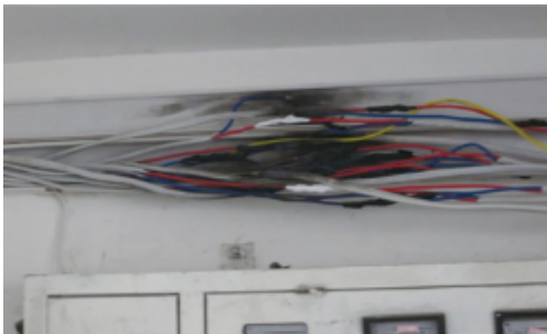
图 5-3: 电线电缆未穿管保护
