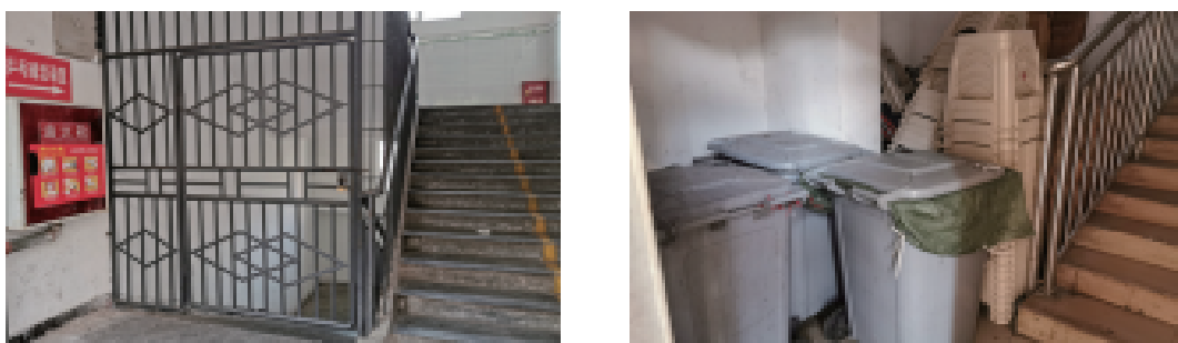
图 1-3 疏散楼梯、走道及安全出口被锁闭、占用、堵塞
