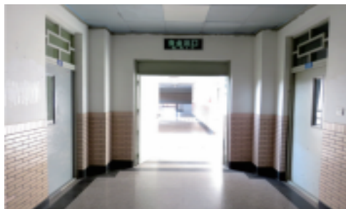
图 1-6 安全出口上方设置的安全出口标志灯
