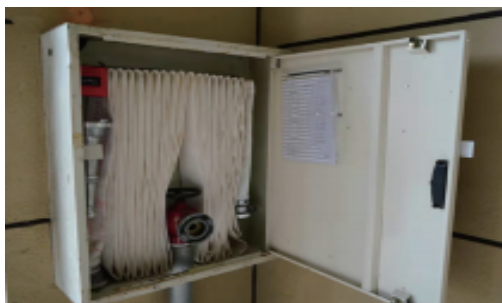
图 4-2 室内消火栓内组件
