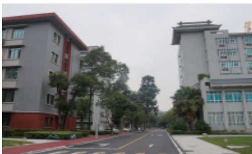
图 2-1 防火间距内空间未被占用
