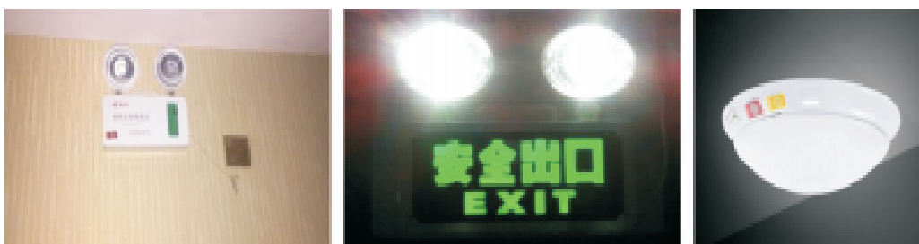
图 1-8 设在墙面上部、出口顶部及吸顶安装的应急照明灯
