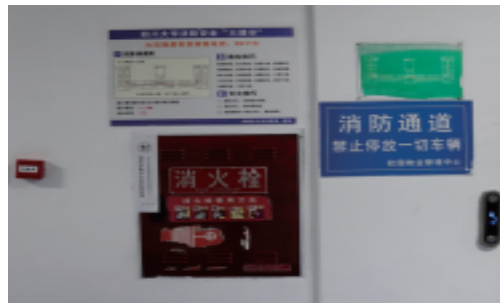
图 4-3消火栓未被遮挡、占用
